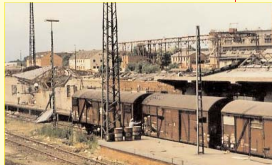
Durch die Explosion entstand hoher Sachschaden. Die Druckwelle schleuderte Dächer weg und zerstörte Gebäude.
